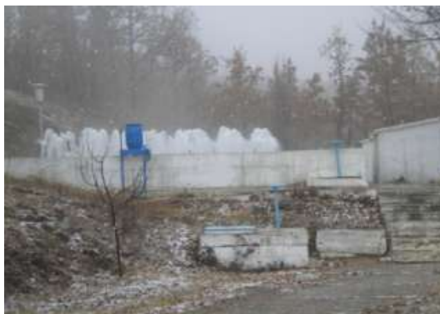
Slika 28- Vodovodna regionalnog stanica u Gračanici vodovoda Priština
