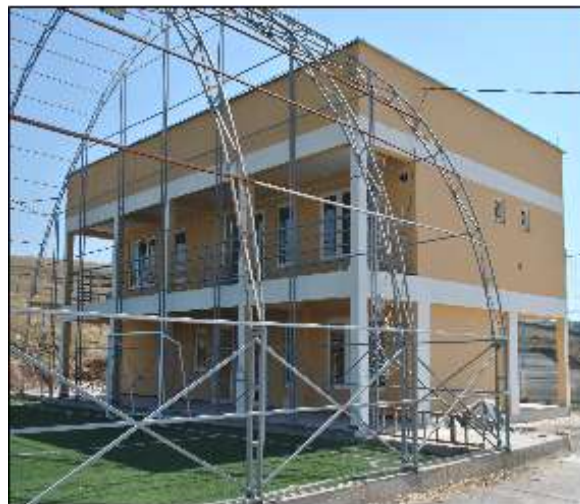
Slika 23- Administrativni objekat sportskog kompleksa
