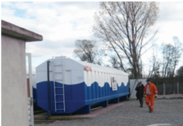
Foto 34. Impianti për pastrimin e ujërave të zeza në Bajicë
