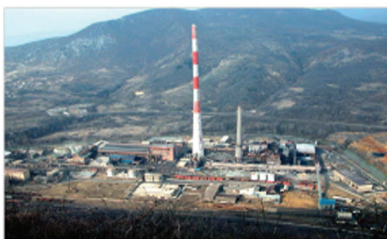
Foto 10. Industria në Zvečan-ndotësi kryesor
