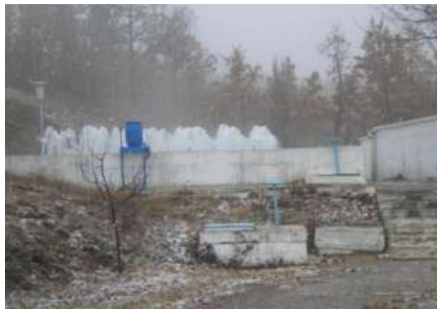
Figura 28- Stacioni i ujësjellësit regjional të Prishtinës në Graçanicë
