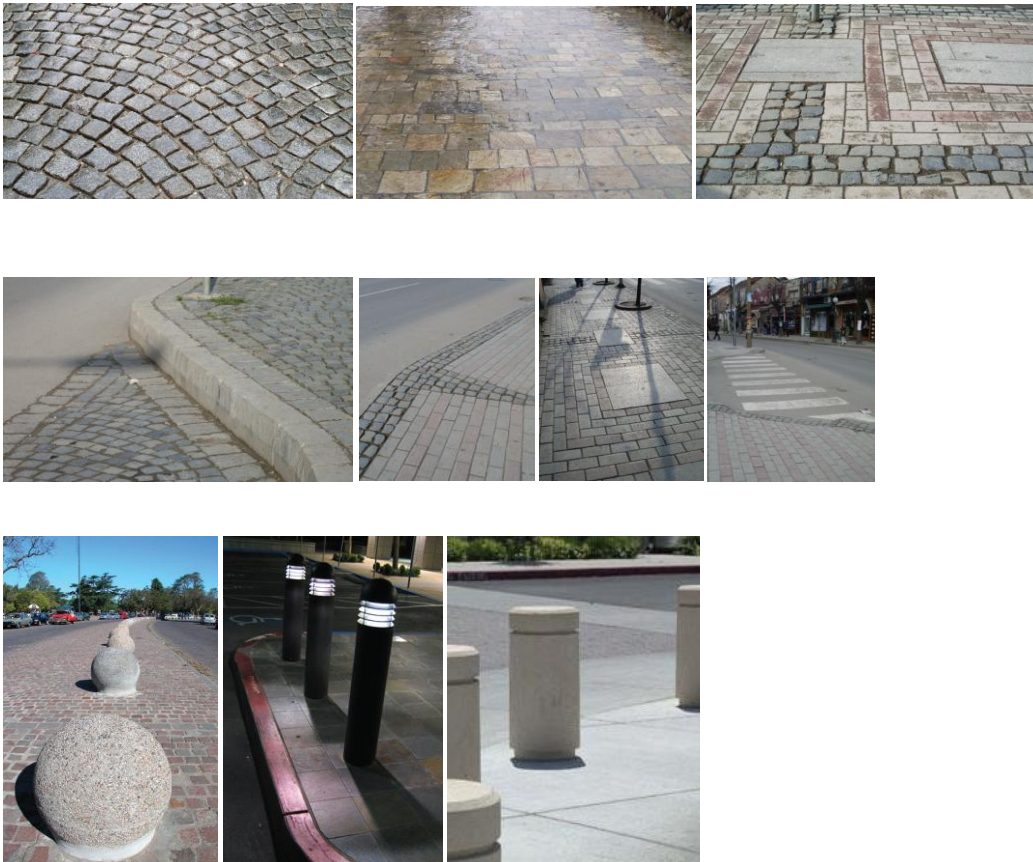
Figura 6.7.1 Materialet e trotuarit dhe shtyllëzave të rrugës
