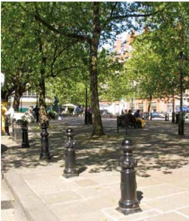
Shtyllat që gjenden më pak se 2m larg njëra tjetrës e kufizojnë qasjen e automjeteve.
