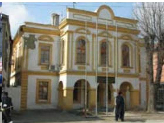
Fig. 16: Ndërtesa e zyrës së Kryetarit të Gjiçanit, në kohën e turqve, Objekti i kajmekamit.
